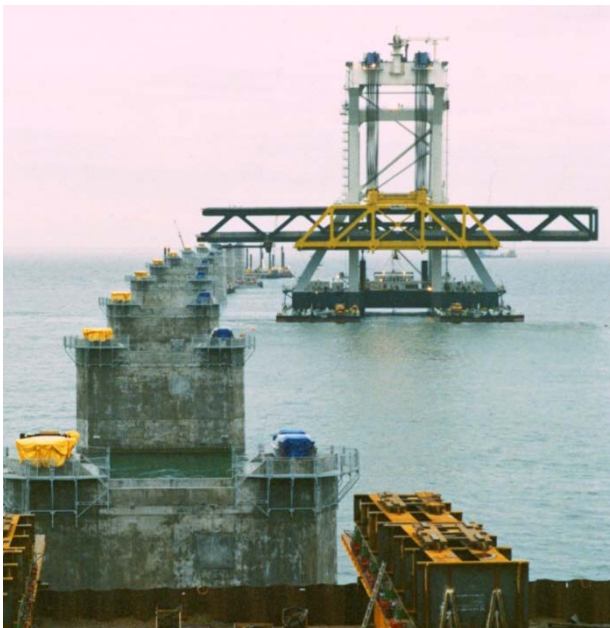
Der schwere Schwimmkran „Svanen“ beim Einbau des ersten Brückentragwerks in die Öresundbrücke. Foto: Øresundsbron
