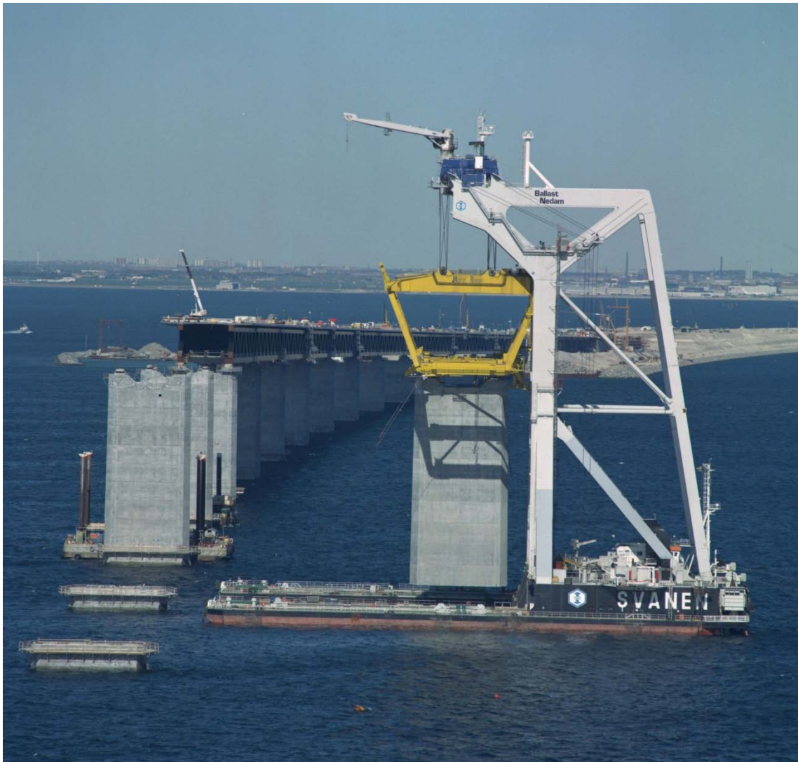
Der riesige Schwimmkran „Svanen“ platziert einen Pfeiler der Öresundbrücke. Foto: Øresundsbron
