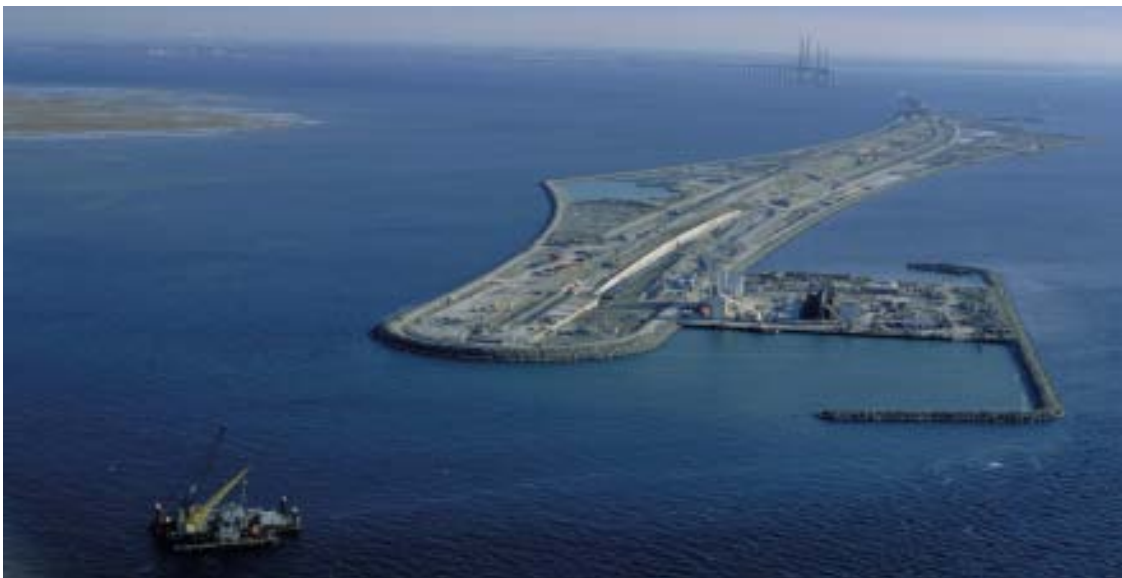
Die künstliche Insel „Peberholm“ während der Bauarbeiten für die Feste Öresundquerung. Foto: Øresundsbron
