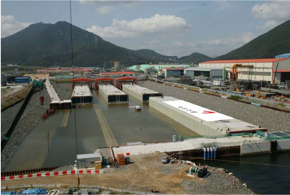
Baudock der Busan-Geoje-Querung in Südkorea
