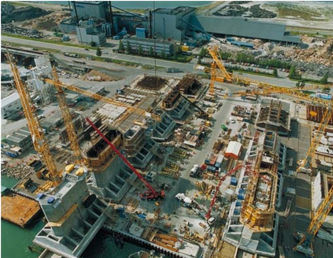
Caissonsproduktion für die Feste Öresundquerung im Nordhafen von Malmö, Schweden. Foto: Øresundsbron
